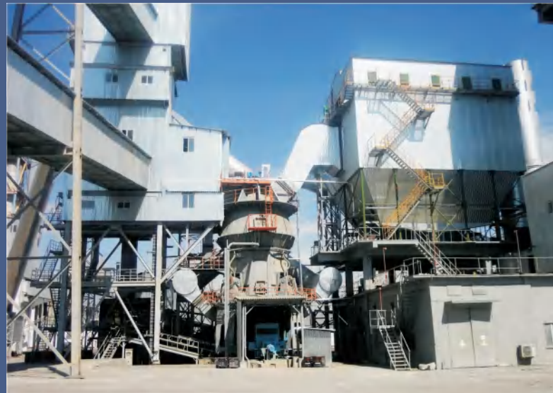
矿渣立磨 Slag vertical mill
