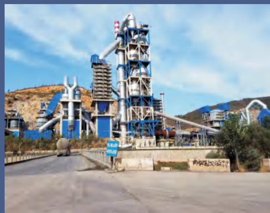
国内水泥承包项目 Domestic cement contracting project
