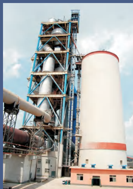
↑ 水泥熟料5级旋风预热器 Cement clinker 5-stage cyclone preheater
