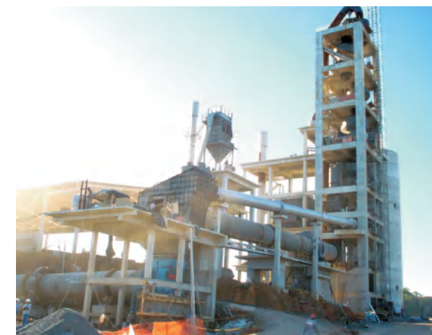
巴西水泥厂施工现场 Brazil cement plant construction site
